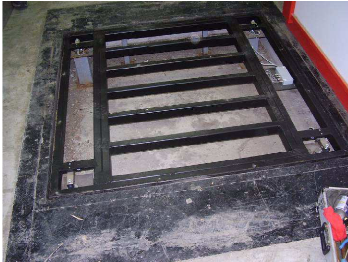
Način ugradnje prijamnika tereta vage u pod
